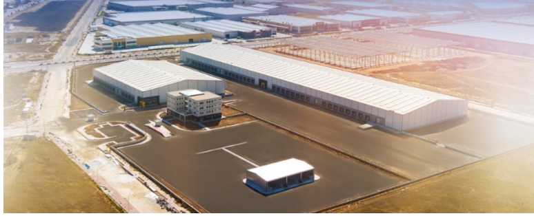
Konya Organize Sanayi Gümrük ve Lojistik Tesisi Panel Çatı
